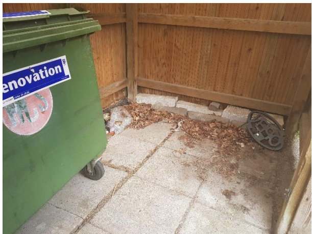
Underminerede fliser
